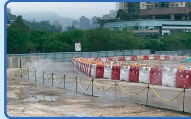
在工地範圍裝置自動灑水系統 Installation of automatic sprinklers system inside work sites
