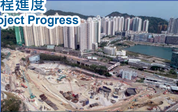
藍田交匯處的土地平整進行中 Site formation at Lam Tin Interchange in progress
