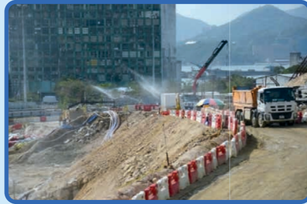
在工地範圍裝置自動灑水系統 Installation of automatic sprinklers system inside work sites
